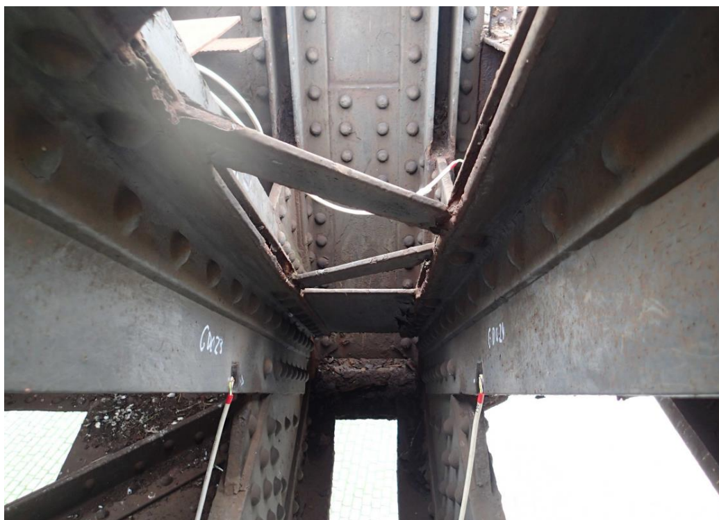
Obr. 21 Znáznornění polohy tenzometru na diagonále
